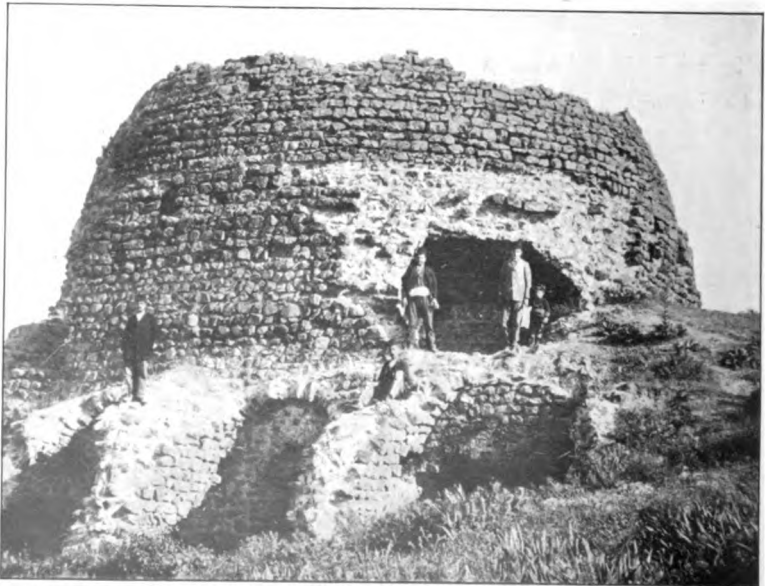
RESTES D'UN HAMMAM ?
